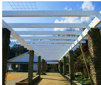
（パーゴラ塗装補修工事）
